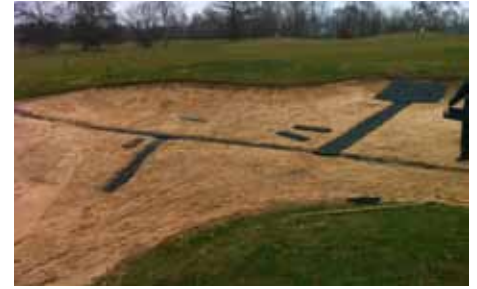
▲ Drainagematten können die Qualität von Bunkern bei starkem Regen verbessern.
